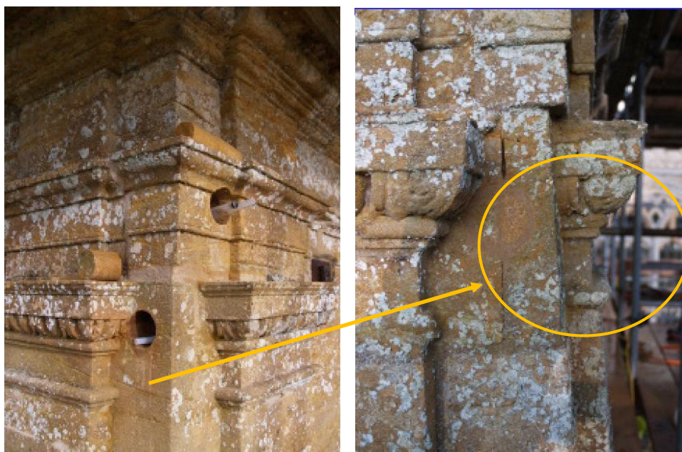
墙面钻孔用原位钻芯修复前后对比
